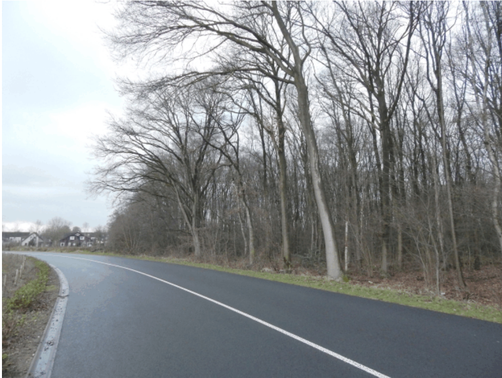
Zuidelijk deel Dassenbos met busbaan
